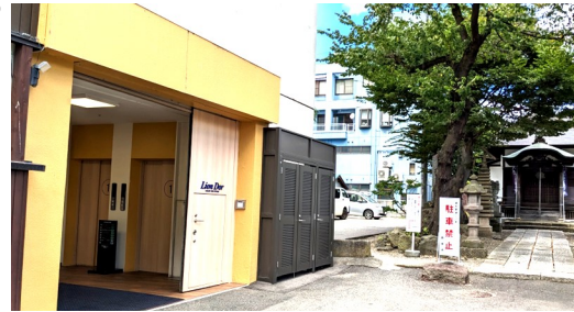
協会ビルの東側入口
